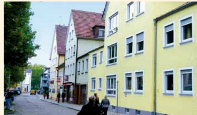
Außenansicht aus Richtung Zehentgasse nach der Renovierung
