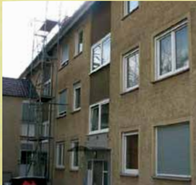
Außenansicht vor der Renovierung
