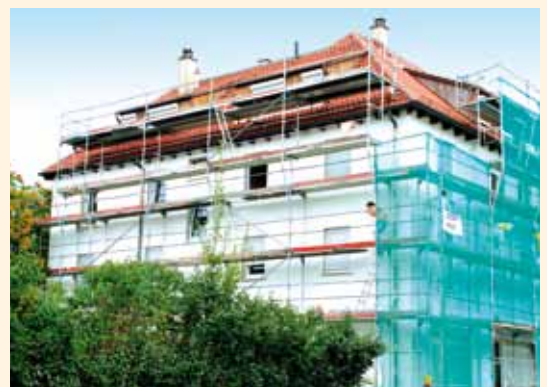
Außenansicht während der Renovierung
