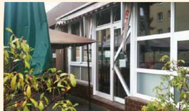
Renovierte Fensterfront der Pizzeria im Erdgeschoss.
