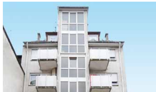
Die Balkone wurden komplett saniert.
