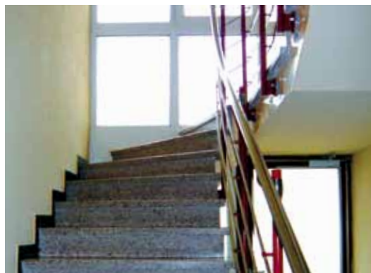
Renoviertes Treppenhaus mit Granitstufen und Edelstahlgeländer
