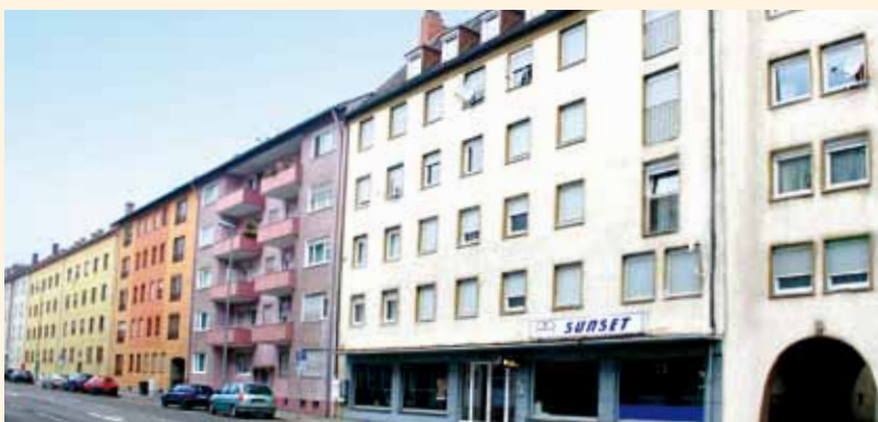
Die Renovierung ist in vollem Gange.
