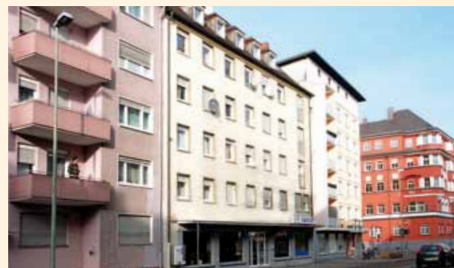
Nach Abschluss der Sanierung wird das Haus zu einem Blickfang in gutem Umfeld.
