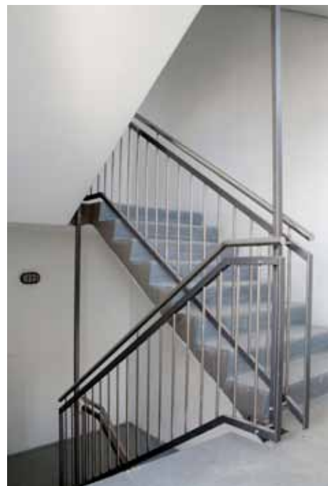
komplett renoviertes Treppenhaus
